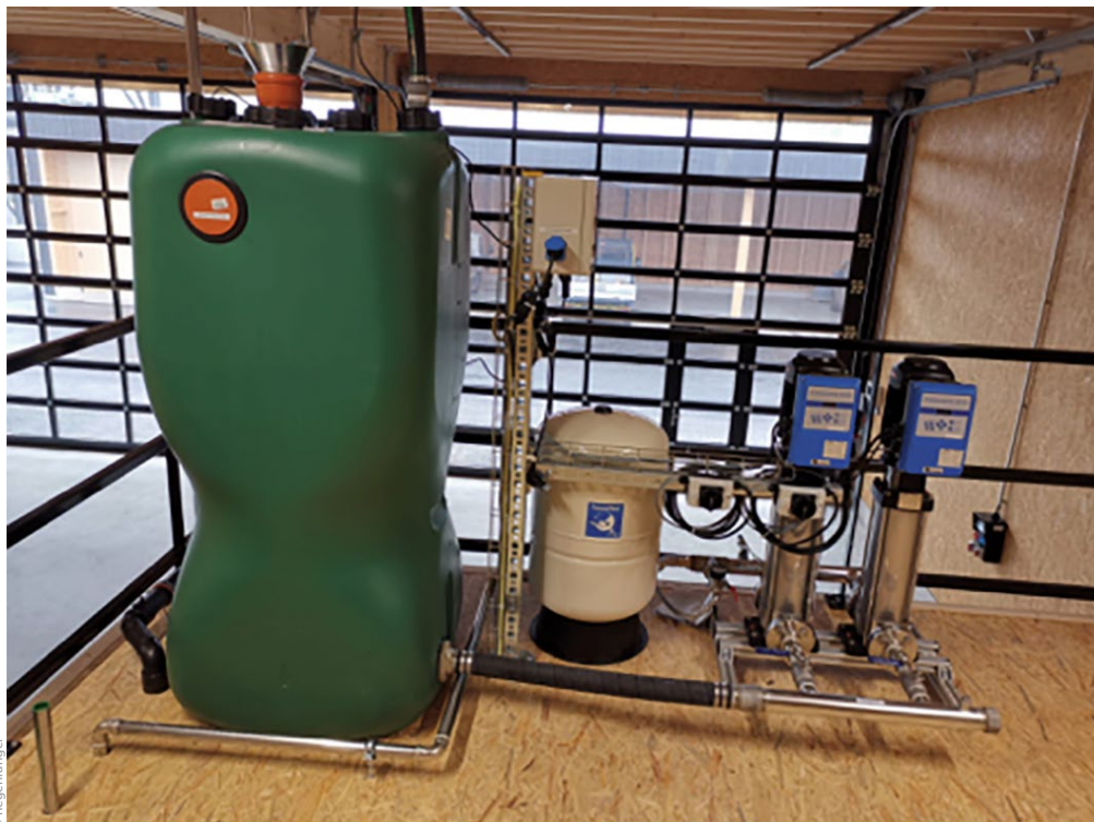
Bild 1: Großanlage für Regenwassernutzung bei einem Werkhof im Kanton Bern/CH
